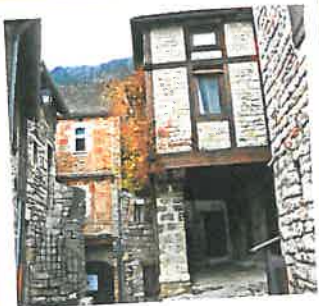
Les ruelles médiévales
