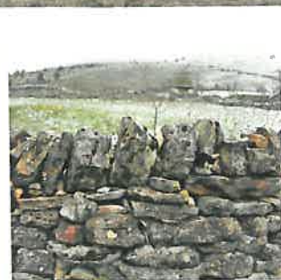
Muret en pierre sèche
